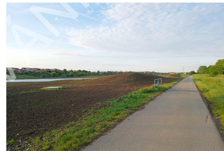
ASFALTOVÁ CESTA K ČOV
